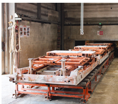
Préparation avant nettoyage
