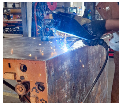
Réparation des faces coffrantes
